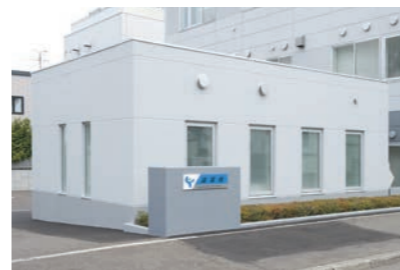
放射能検査室(検査棟)
